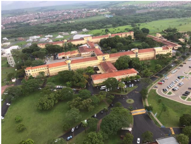
Hospital Emílio Carlos - Campus Sede da UNIFIPA
