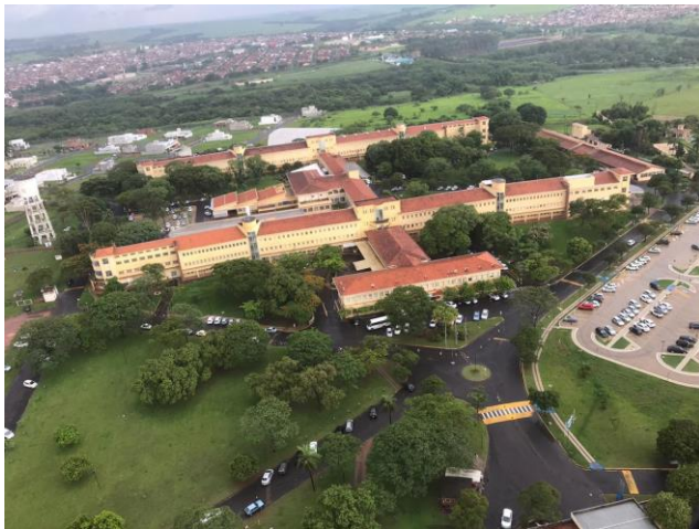
Hospital Emílio Carlos - Campus Sede da UNIFIPA
